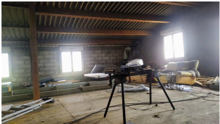
Ph 09 - Vue arrière de l'extension ETAGE
