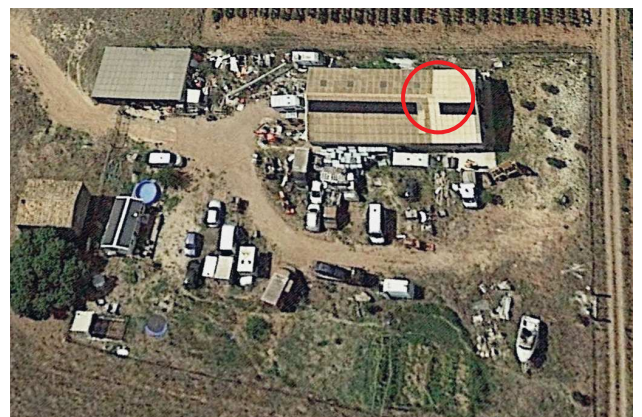
Ph 01 - Vue aérienne du hangar RULENCE
