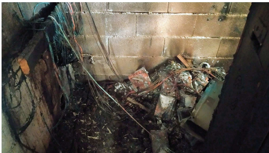
Ph 06 - Vue de la zone de déblaiement pour analyses
