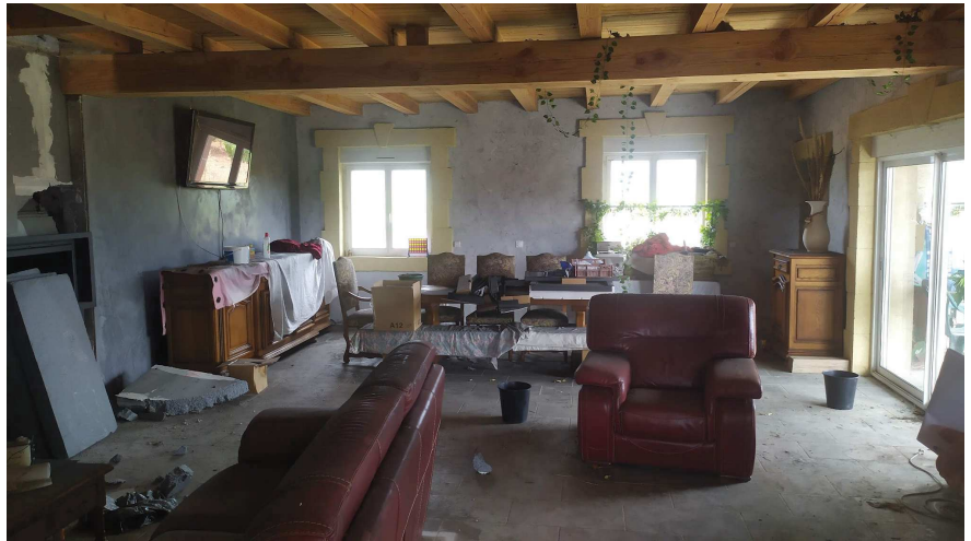
Ph 08 - Vue arrière de l'extension RDC
