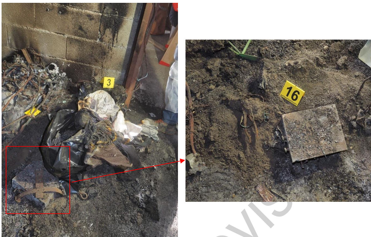
Figure 7 - Boitier métallique à l'avant de la zone des batteries de stockage
