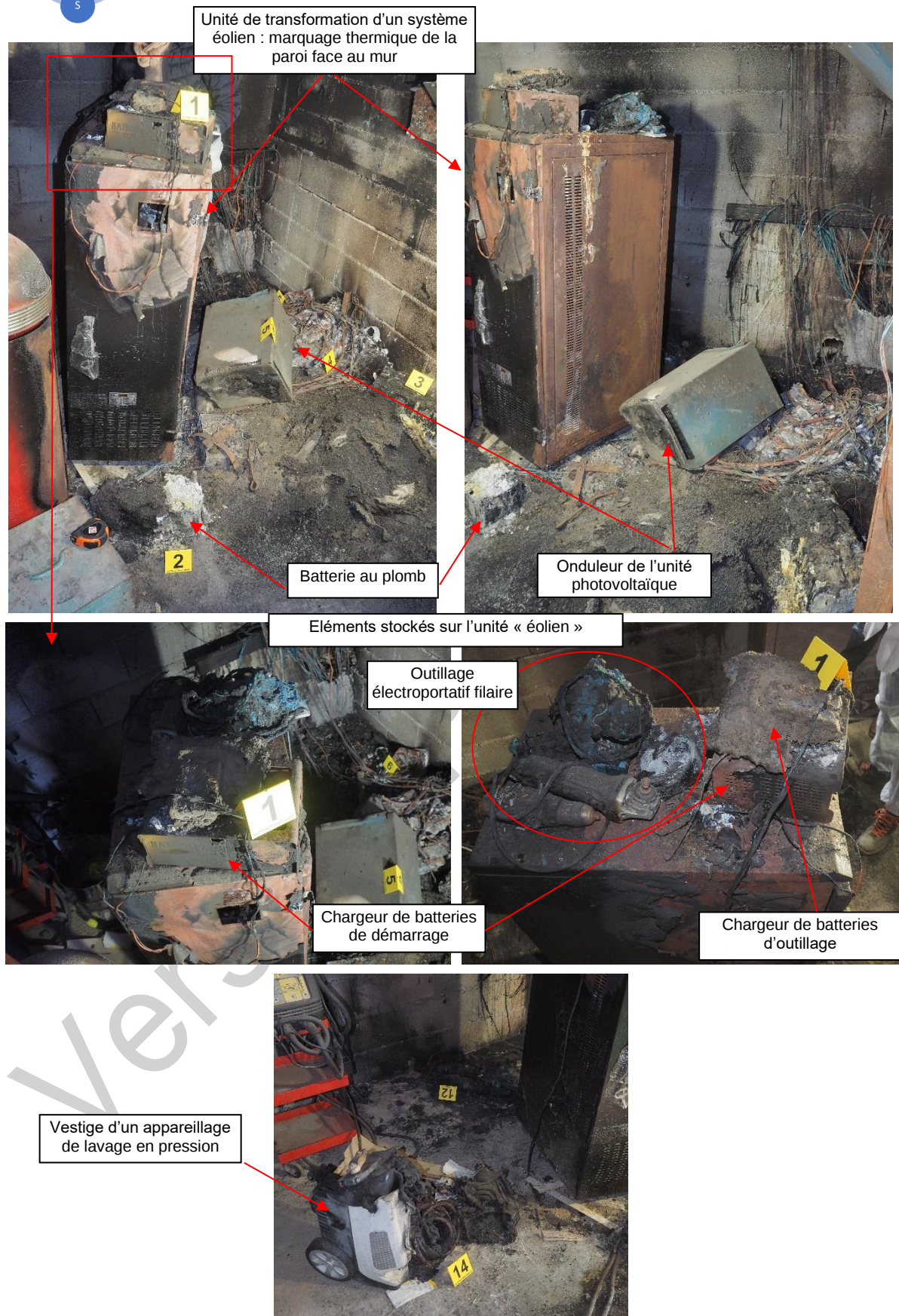
Figure 4 - Premiers éléments retirés à l'avant de la zone des batteries de stockage
