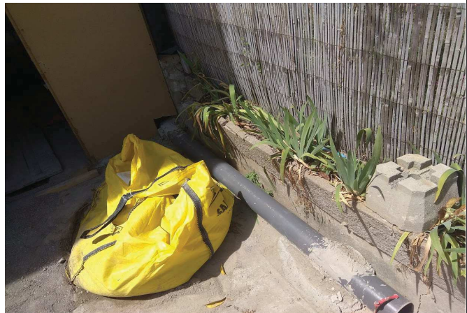
Évacuation de sécurité des EP / Ø 160 mm - 231 ▼
