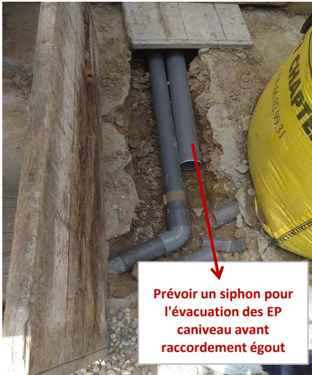
**Prévoir un siphon pour l'évacuation des EP caniveau avant raccordement égout**
