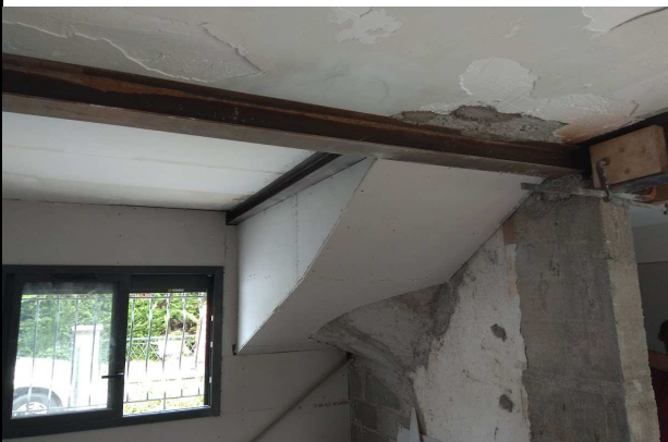
▼ 182 - RDC / HEA 100 mm et encloisonnement volet d'escalier
