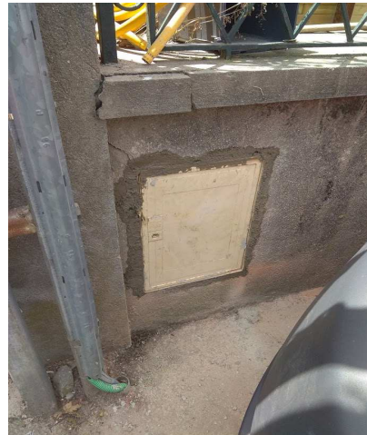
Pose du coffret électrique en façade clôture - 187 ▲
