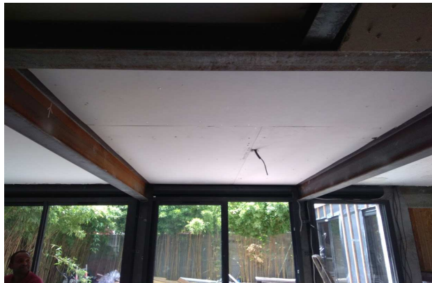
Faux plafond Séjour (BA13) - 183 ▲
