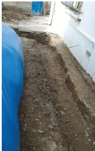
▼ 09 - Fouille pour renfort de fondation - 10 ▼
