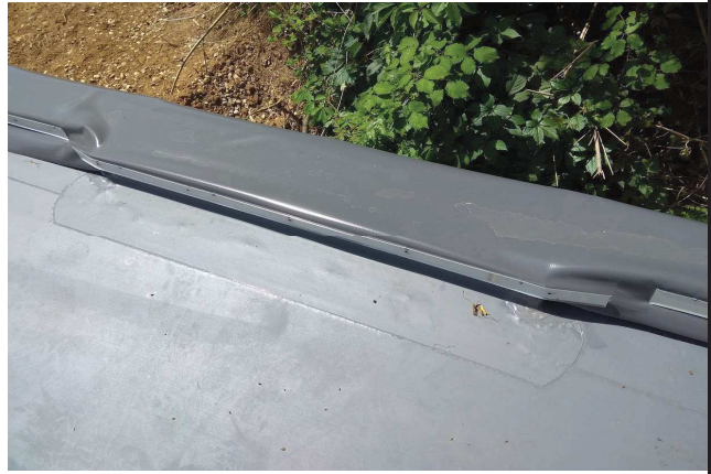
Obturation provisoire de l'édicule - 172 ▲
