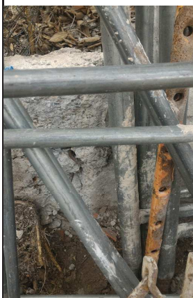
▼ 04 - Reconstruction du mur de soutènement
