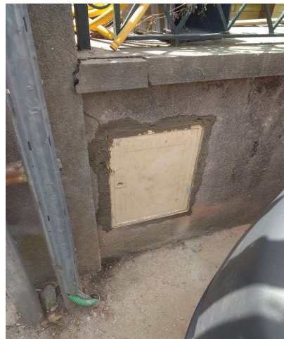
Pose du coffret électrique en façade clôture - 187 ▲
