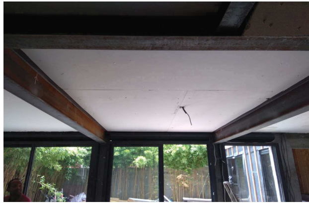
Faux plafond Séjour (BA13) - 183 ▲
