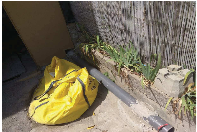
Évacuation de sécurité des EP / Ø 160 mm - 231 ▼
