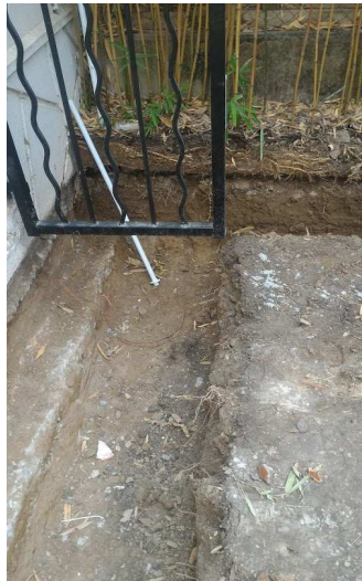
▼ 09 - Fouille pour renfort de fondation - 10 ▼
