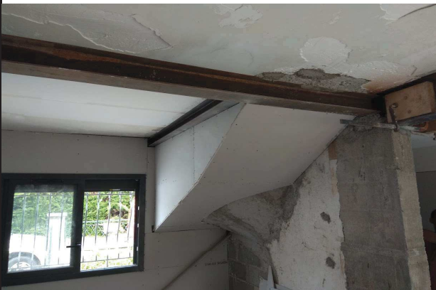
▼ 182 - RDC / HEA 100 mm et encloisonnement volet d'escalier
