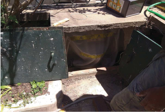
▼ 228 - Protection compteur électrique par EDF
