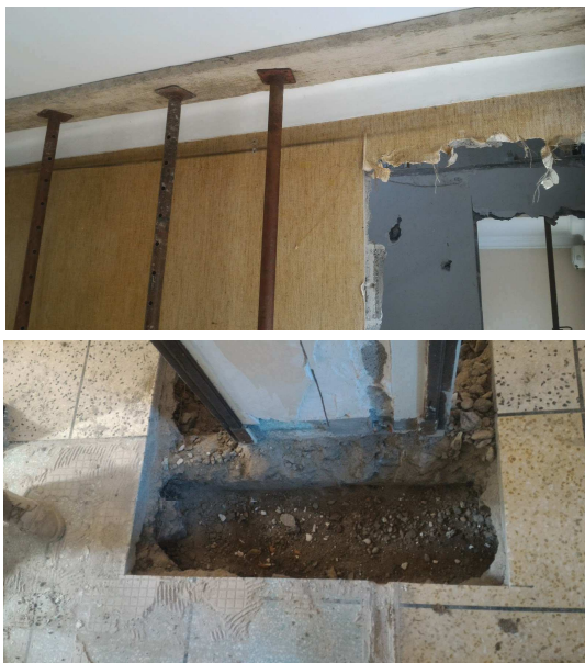
Fouille pour semelle de fondation en attente - 15 ▲
