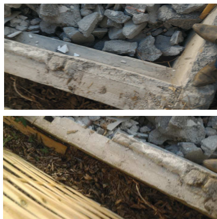
▲ - 08 - Drain et étanchéité à prévoir
