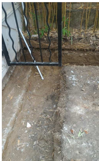
▼ 09 - Fouille pour renfort de fondation - 10 ▼
