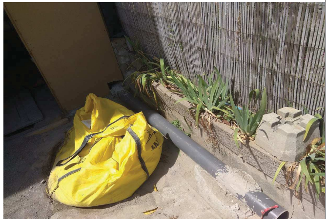
Évacuation de sécurité des EP / Ø 160 mm - 231 ▼
