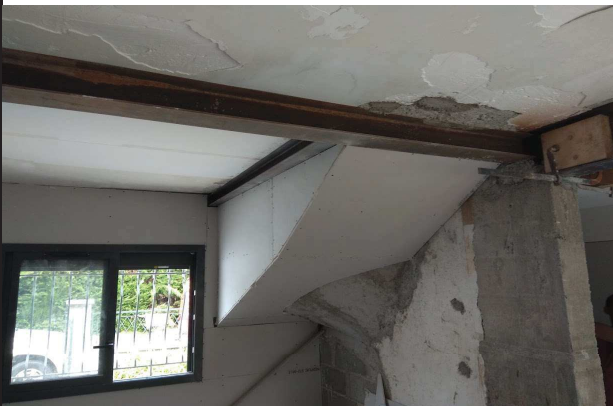
▼ 182 - RDC / HEA 100 mm et encloisonnement volet d'escalier
