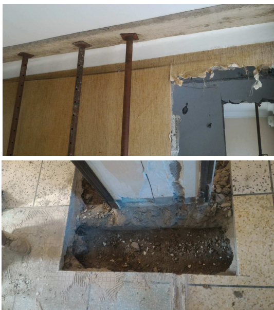
Fouille pour semelle de fondation en attente - 15 ▲
