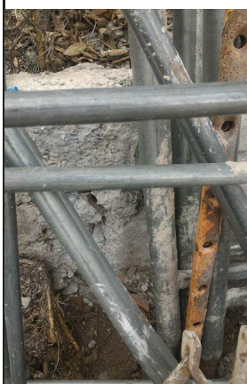
▼ 04 - Reconstruction du mur de soutènement
