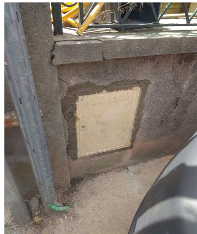
Pose du coffret électrique en façade clôture - 187 ▲
