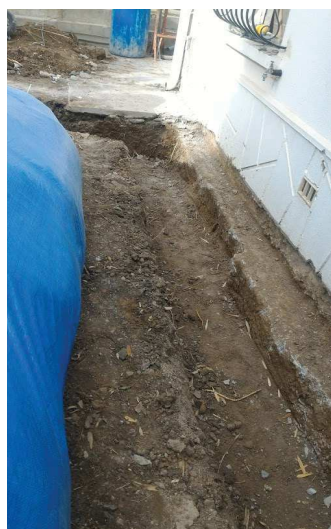
▼ 09 - Fouille pour renfort de fondation - 10 ▼
