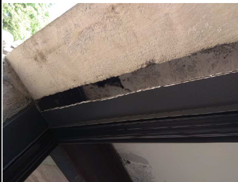
▼ 120 - Défauts d'alignement des linteaux / ▼ 122 - SALON (x3) En attente de VR - 123 ▼
