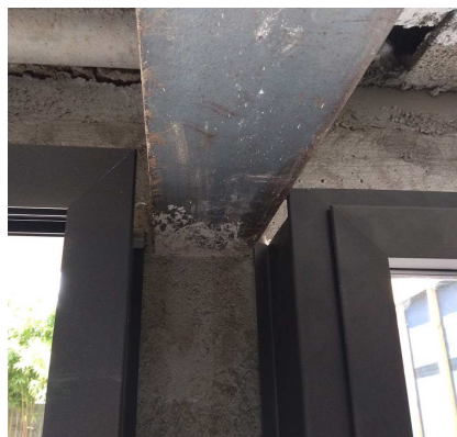
▼ 124 - Défauts d'alignement des linteaux / ▼ 125 - Malfaçons, cadres endommagés - 126 ▼ etc....
