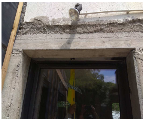
▼ 124 - Défauts d'alignement des linteaux / ▼ 125 - Malfaçons, cadres endommagés - 126 ▼ etc....
