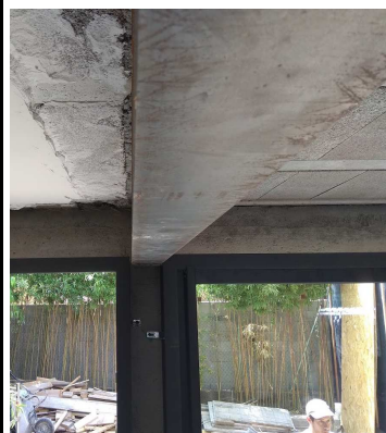
▼ 124 - Défauts d'alignement des linteaux / ▼ 125 - Malfaçons, cadres endommagés - 126 ▼ etc....
