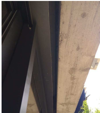
▼ 120 - Défauts d'alignement des linteaux / ▼ 122 - SALON (x3) En attente de VR - 123 ▼
