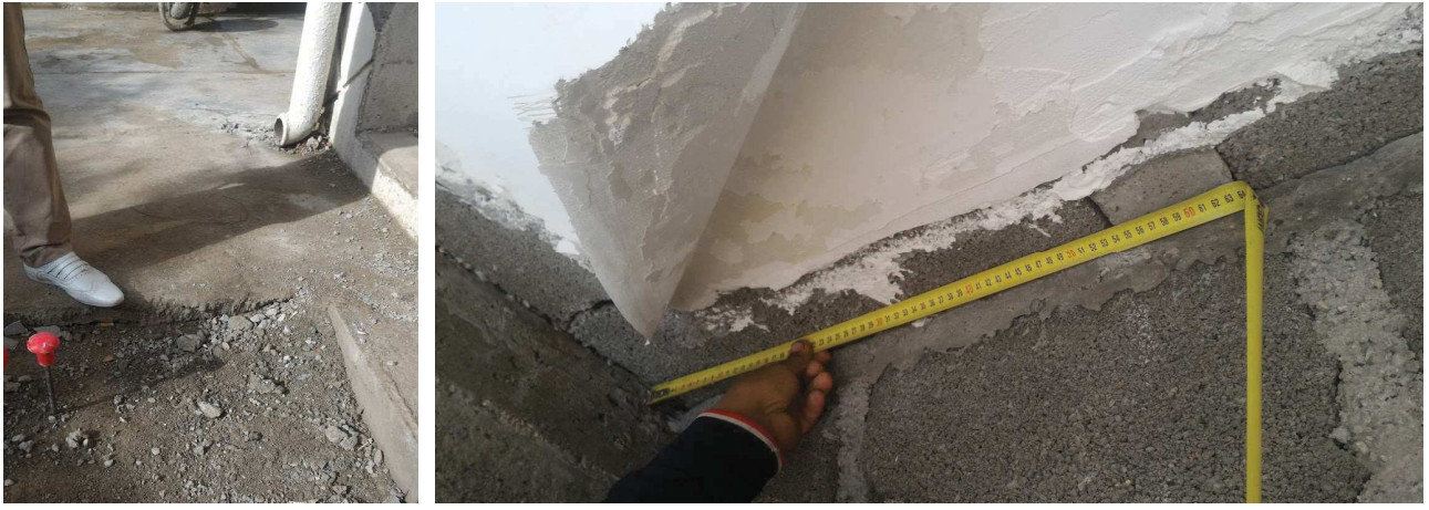
▼ 31 - Pose d'un caniveau à (-15 cm) / Trottoir
