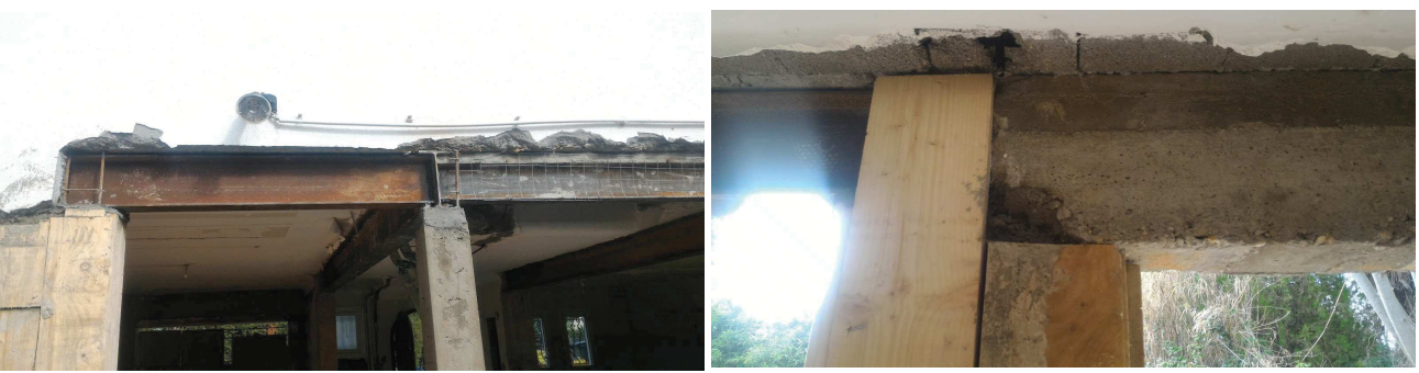
▼ 33 - En attente d'armature pour enrobage
