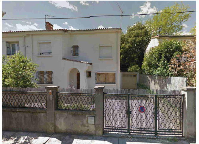
Façade Sud existante
