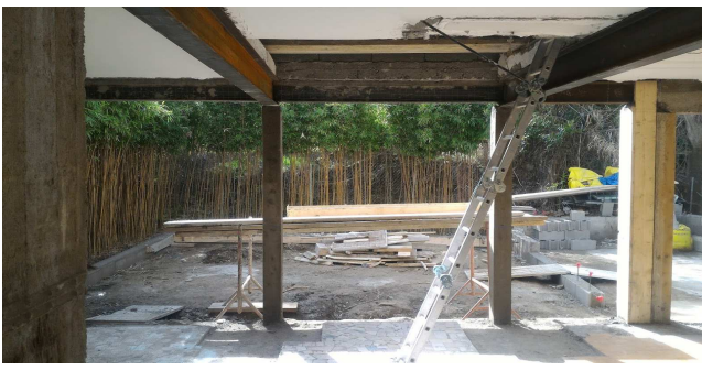
▼ 35 - Vue d'ensemble (poteaux enrobés)
