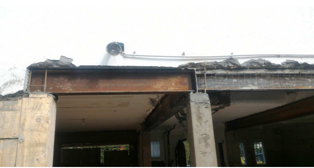
▼ 33 - En attente d'armature pour enrobage
