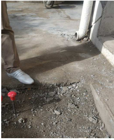
▼ 31 - Pose d'un caniveau à (-15 cm) / Trottoir
