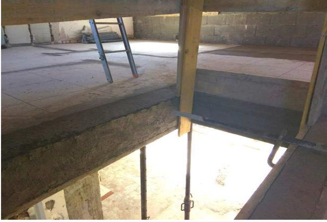
▼ 71- Sous face escalier avant décoffrage et finition plâtre - 72 ▼
