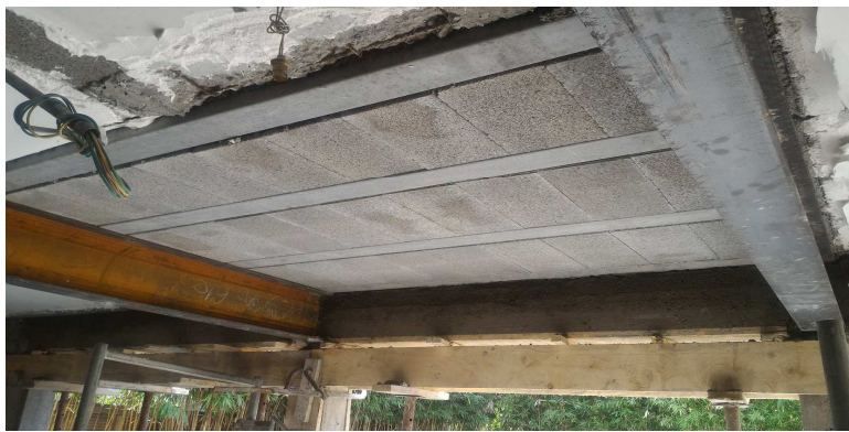
Remplissage ancienne trémie - 41 ▼
