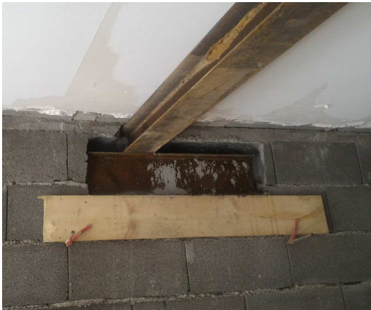
▼ 45 - Sommier en cours
