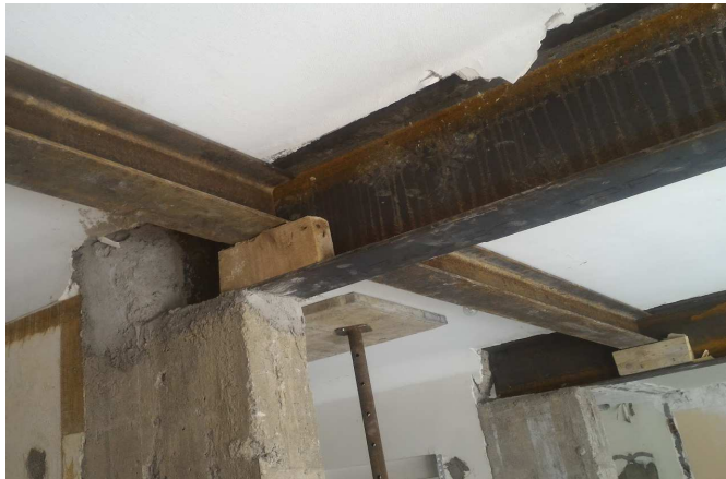
Appuis provisoires HEA 120 mm - 46 ▼
