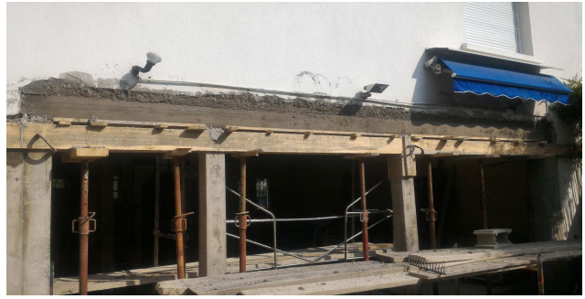
Linteau BA / IPN en façade SUD - 39 ▼
