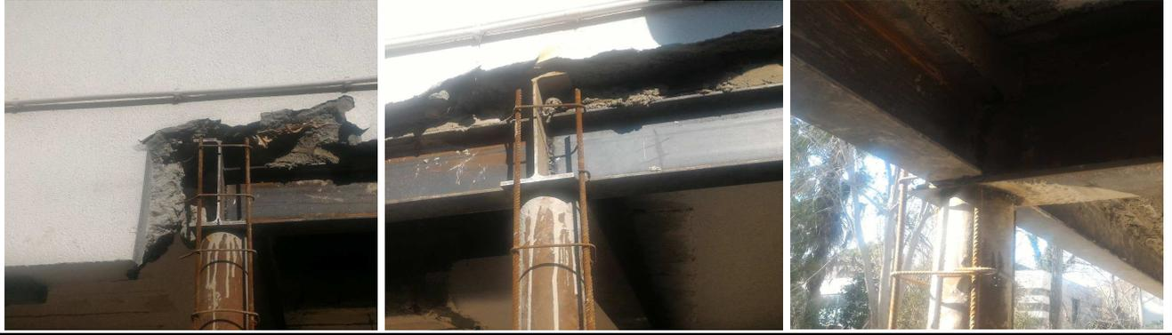
▼ 26 - Appui poutres (IPN 260) sur pilier BA en attente de "clavetage"
