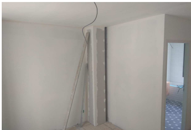
▼ 236 - Contre cloison du galandage du bureau à créer (R+1)
