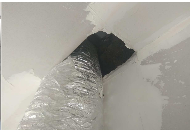
Finition plâtrerie en attente des grilles CLIM. - 235 ▼
