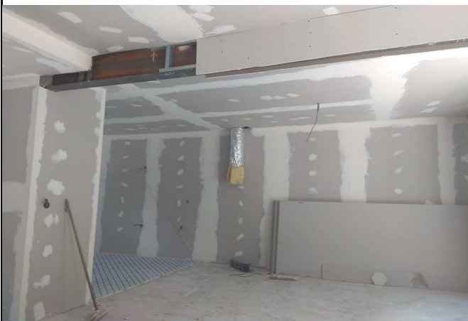
▼ 234 - Coffrages des l'IPN à démonter
