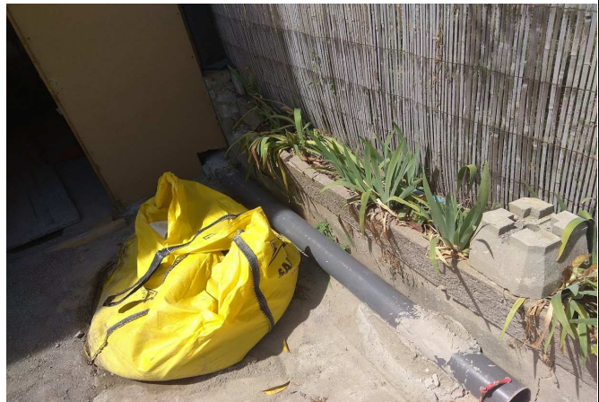
Évacuation de sécurité des EP / Ø 160 mm - 231 ▼
