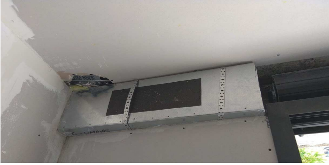
▼ 227 - Repositionnement Plenum (CLIMAVIE) + Pose cornière pour coffre VR (SONIMEN)
