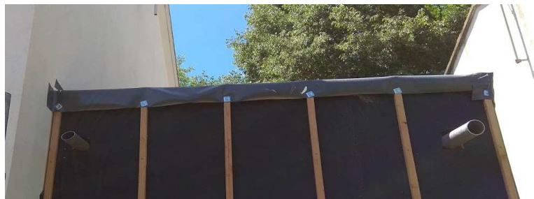
▲ 206 - En attente de calfeutrement du pare-pluie et des naissances EP
