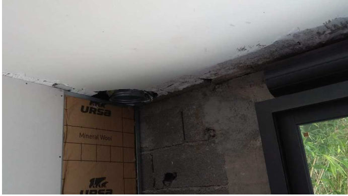
▼ 199 - Liaison du coffre VR et Plénum pour soufflage clim.
