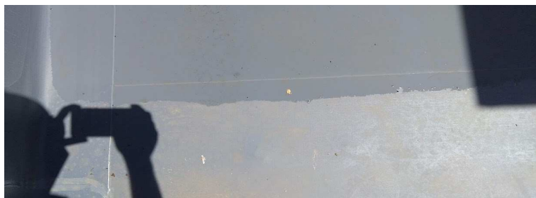
▼ 205 - Mise en charge de l'étanchéité pour vérification
