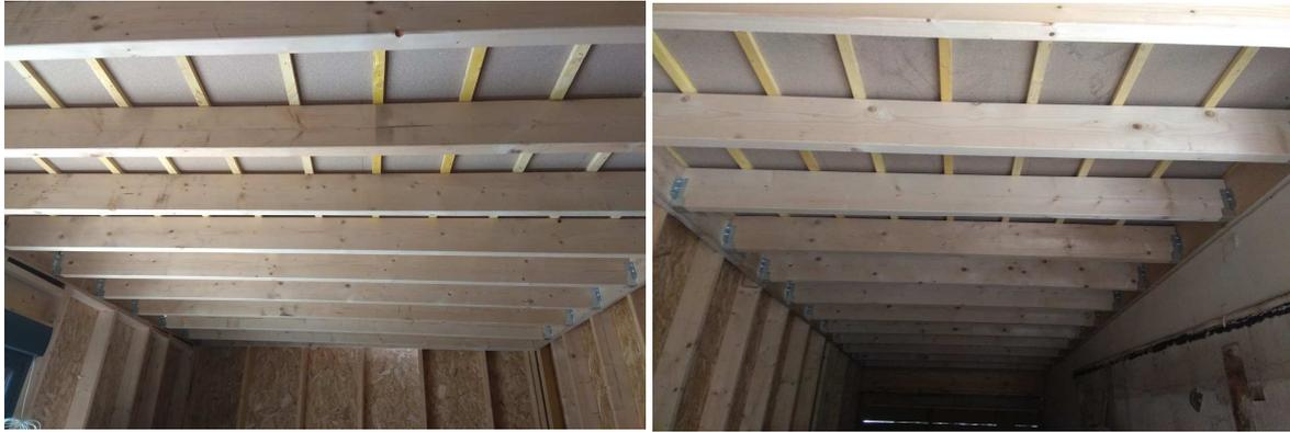
▼ 156 - Détail & précision de mise en œuvre de l'isolation thermique et du pare-vapeur
