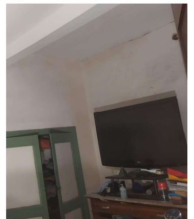
Chambre RDC côté cour - 06/03/2023 Source : L.Cascales
