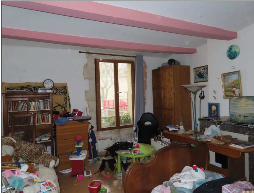
Les menuiseries ont été remplacées.
