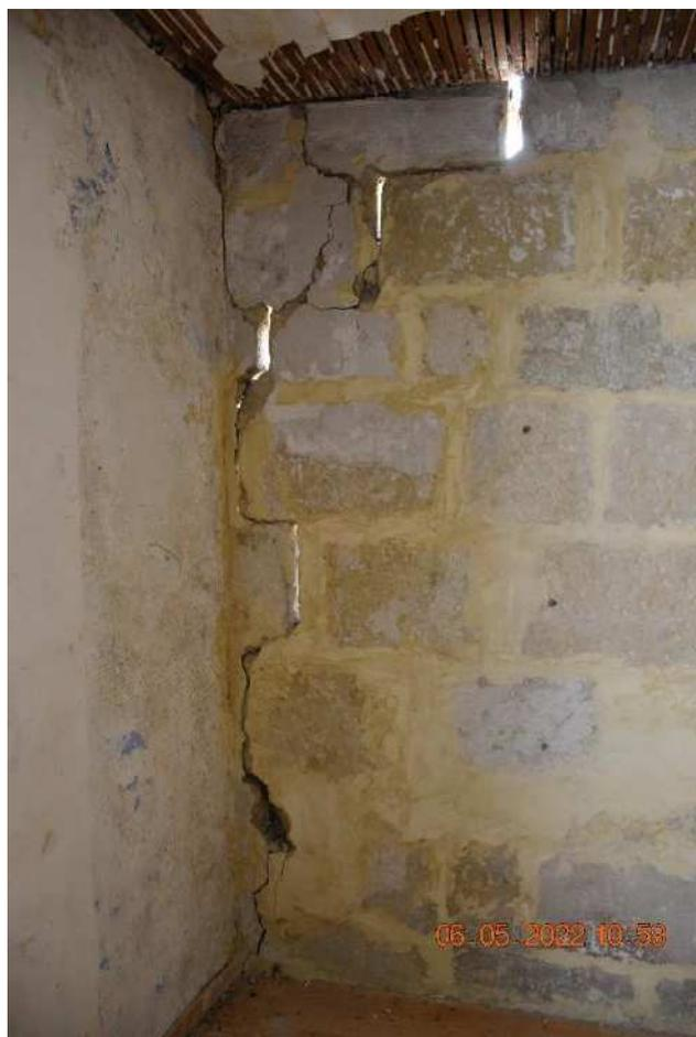
Toujours au deuxième étage, la chambre côté Sud présente des fissures. Les dommages observés sont sans commune mesure avec ceux observés côté Nord de ce même niveau.
