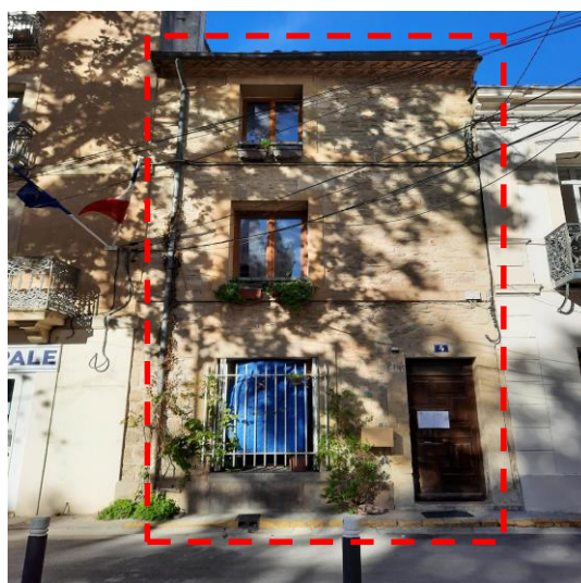
Photos de la façade sur rue le 22 Novembre 2021
