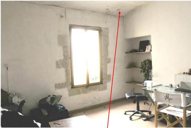
R2 vue de la chambre sur rue
