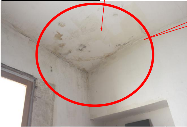
R2 vue de la chambre sur rue
