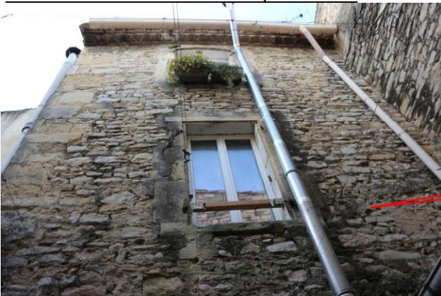
R1 et R2 vue de la cour arrière sur façade cuisine
