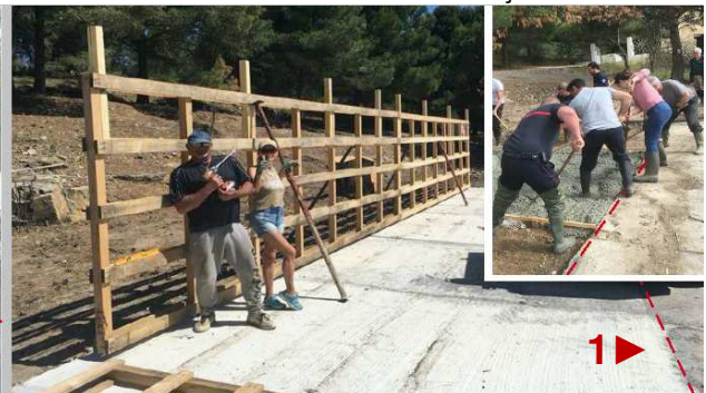
Photo 24 - Ossature du mur sellerie CTE façade Nord-ouest
