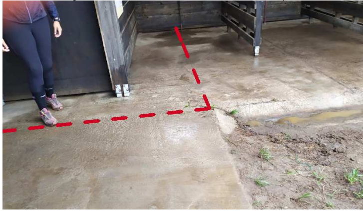
Photo 24 - Angle des 2 ailes de stabulation + entrée Hall (accueil bombes et harnais)
