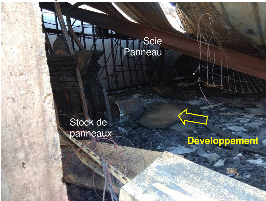
Photo n°07 - Angle sud-ouest de l'atelier / Vue intérieure
