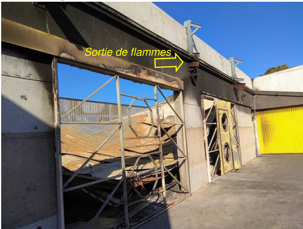
Photo n°05 - Façade Sud de l'atelier / Vue extérieure
