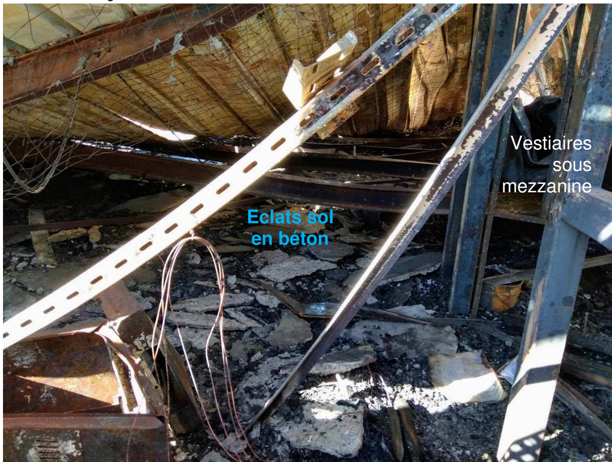
Photo n°08 - Angle sud-est de l'atelier / Vue intérieure
