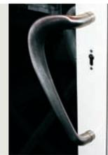
**Variante 1** : La manœuvre s'effectuera par poignée de tirage tube double en « C » en aluminium, à fixations invisibles (Sépalumic réf.: 92200). Ces poignées seront de teinte : .....
