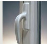
**Variante 1** : Compte-tenu du verrouillage *inversé* la manœuvre s'effectuera par poignée à clef à tourner, en aluminium, et à fixations invisibles (Sépalumic réf.: 40422). Cette poignée, tournée vers le bas, indiquera la position fermée, en horizontale, permettra l'ouverture à soufflet, et orientée vers le haut (après décondamnation avec la clef), autorisera l'ouverture à la française. Ces poignées seront de teinte : .....
