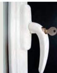
**Variante 2 :** La manœuvre s'effectuera par poignée amovible à tourner, en aluminium, et à fixations invisibles (SEPALUMIC réf.: 40342). Ces poignées seront de teinte : .....
