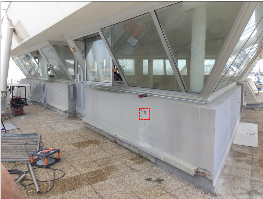
Photographie du positionnement des carottes C1 et C2 côté Nord
