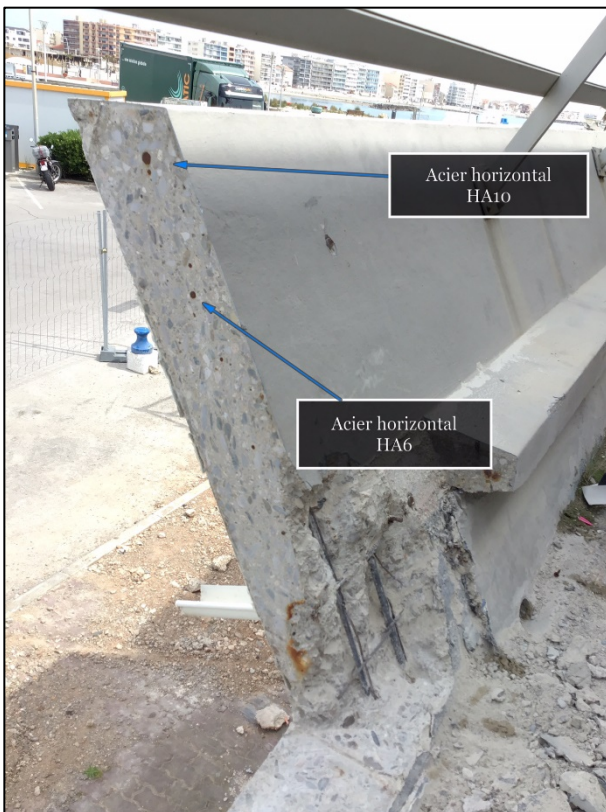
Coupe transversale du garde-corps (aciers longitudinaux)
