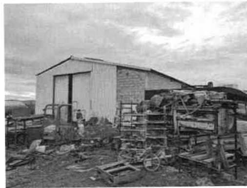
Hangar Construit année 1995
