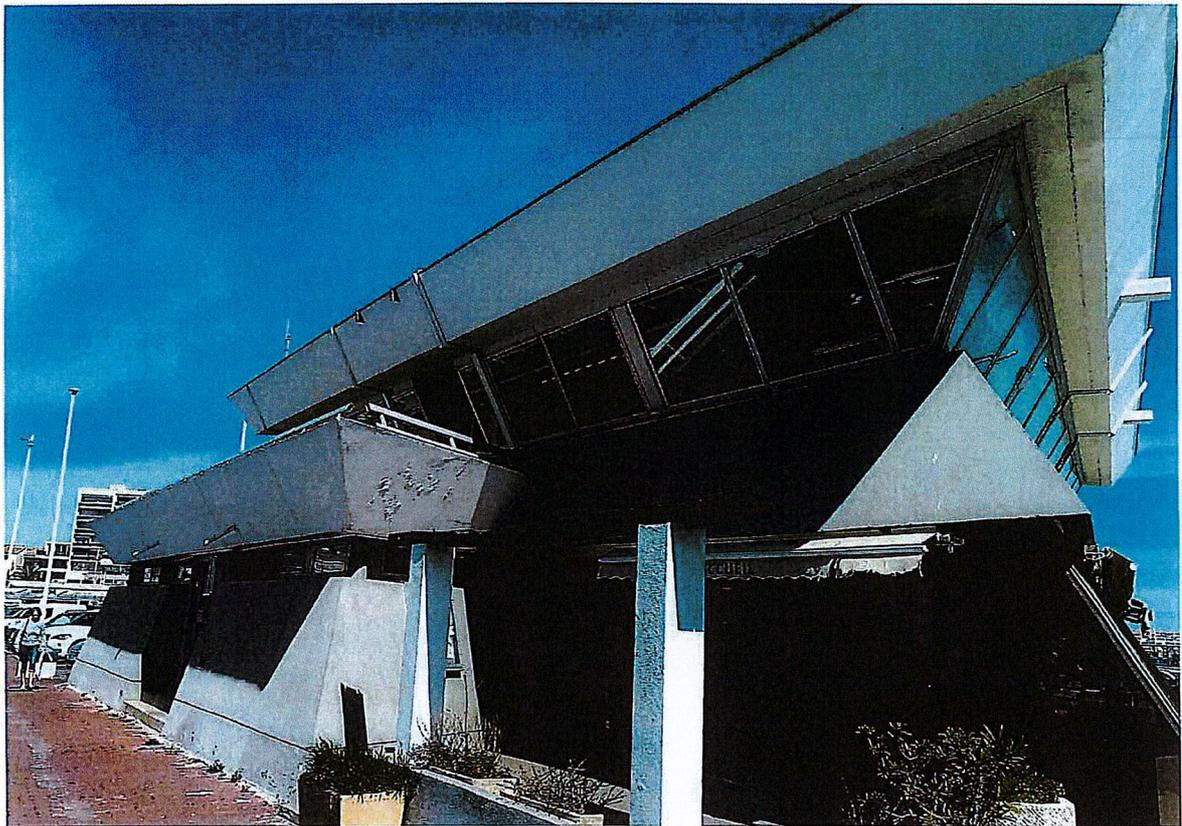
*Vue de la façade contre les quais avec la partie du RDC en pente vers l'extérieur et le garde-corps de la terrasse partielle du R+1
